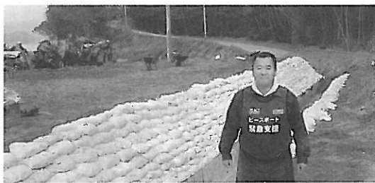
水路の復旧作業
