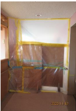
陽性者と陰性者の生活スペースを仕切り、感染が拡大を防止しました。
